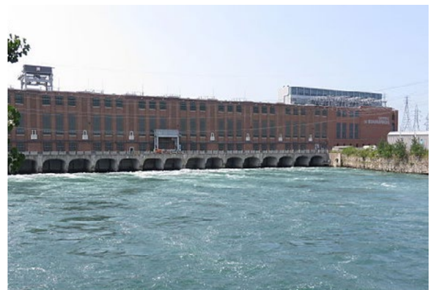
Centrale de Beauharnois, au Québec. Photo by Gilles Douaire
