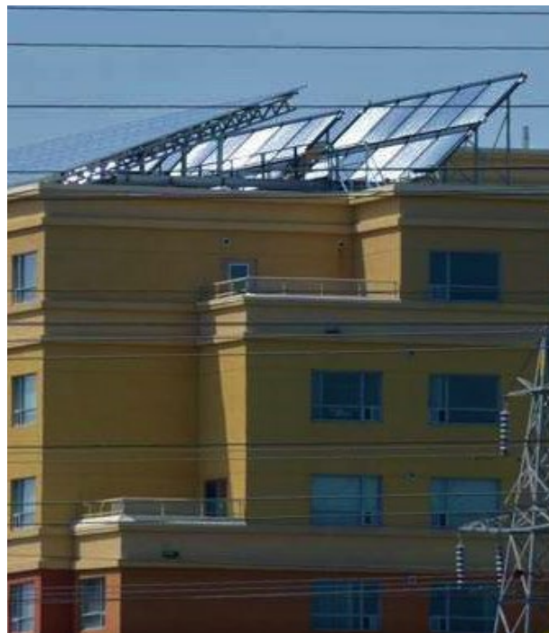
Panneau solaire sur plusieurs logements, Dundas, ON. Photo de Kim Perrotta.
