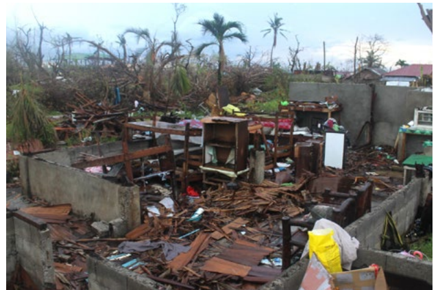
Maison détruite par un orage. Photo par Acrylik.
