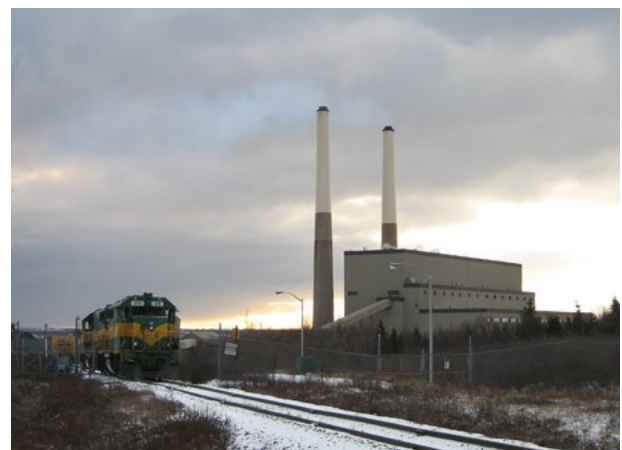
Centrale de Lingan dans la municipalité régionale du Cap-Breton, en Nouvelle-Écosse. Ceci est sur l'île du Cap Breton, dans la province de la Nouvelle-Écosse, Canada. Photo de Ken Heaton.
